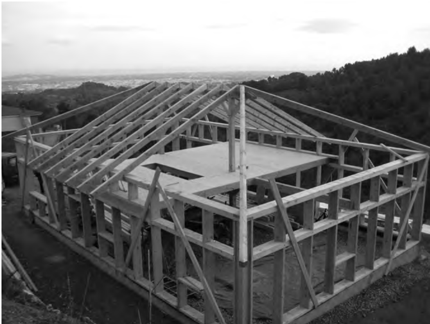
Estructura de madera de casa en Cataluña, 2014.
